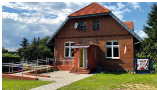
Fotografia 2.4. Budynek świetlicy wiejskiej w Mniszku
