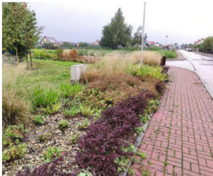
Fotografia 2.20. Ogród deszczowy w miejscu narażonym na podtopienia w centrum Piasecznej Górki
