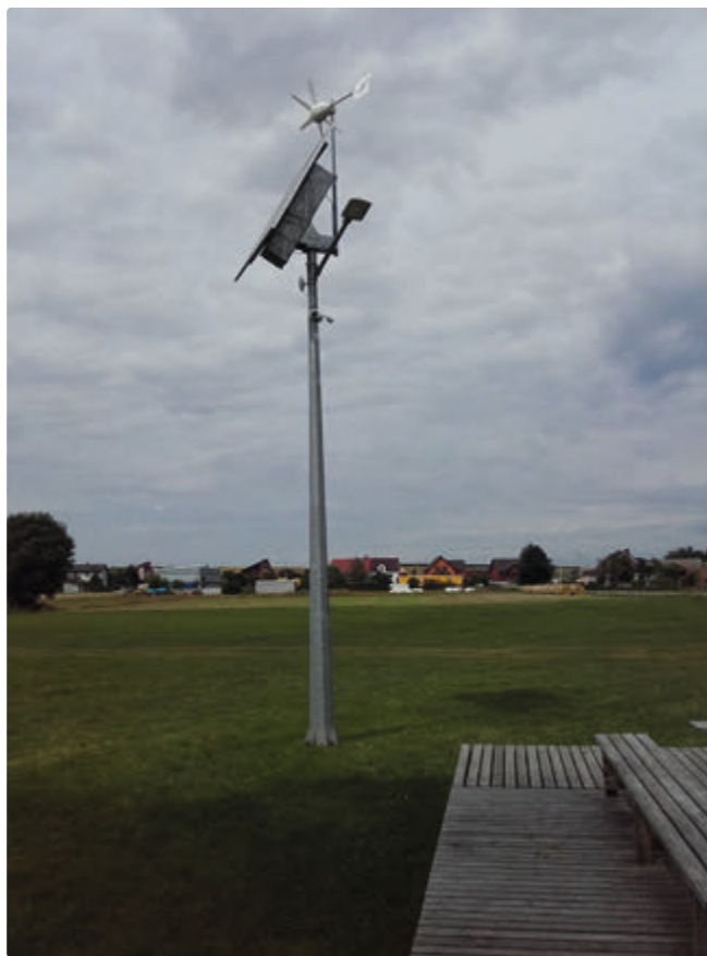
Fotografia 2.8. Widok na bezprzewodową stację meteorologiczną w Łuszczanowie
