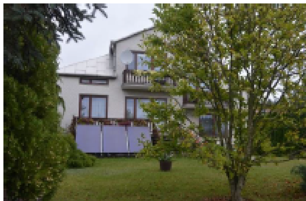
Instalacje solarne na budynku mieszkalnym.
